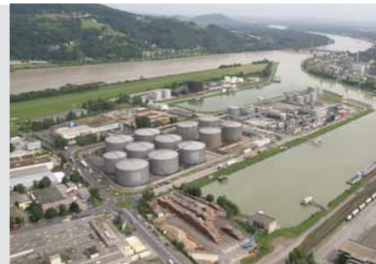
Blick auf den Linzer Standort der Erdöl-Lagergesellschaft m.b.H. (ELG).
